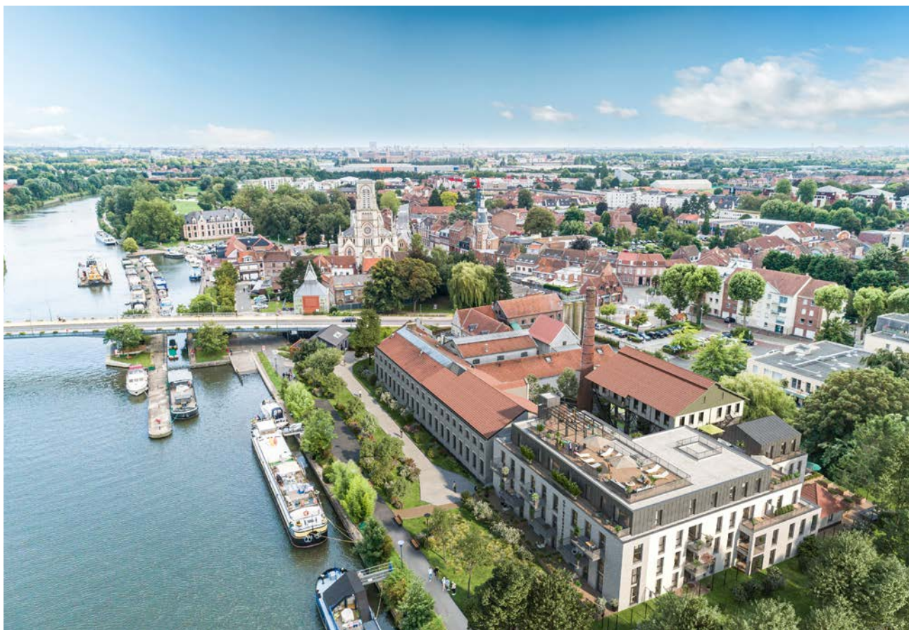
Située le long de la Deûle à Wambrechies, la distillerie Claeysens bénéficie d'une localisation privilégiée. Sa réhabilitation en futur lieu hybride vient compléter l'offre de la ville. ©VERTEX
