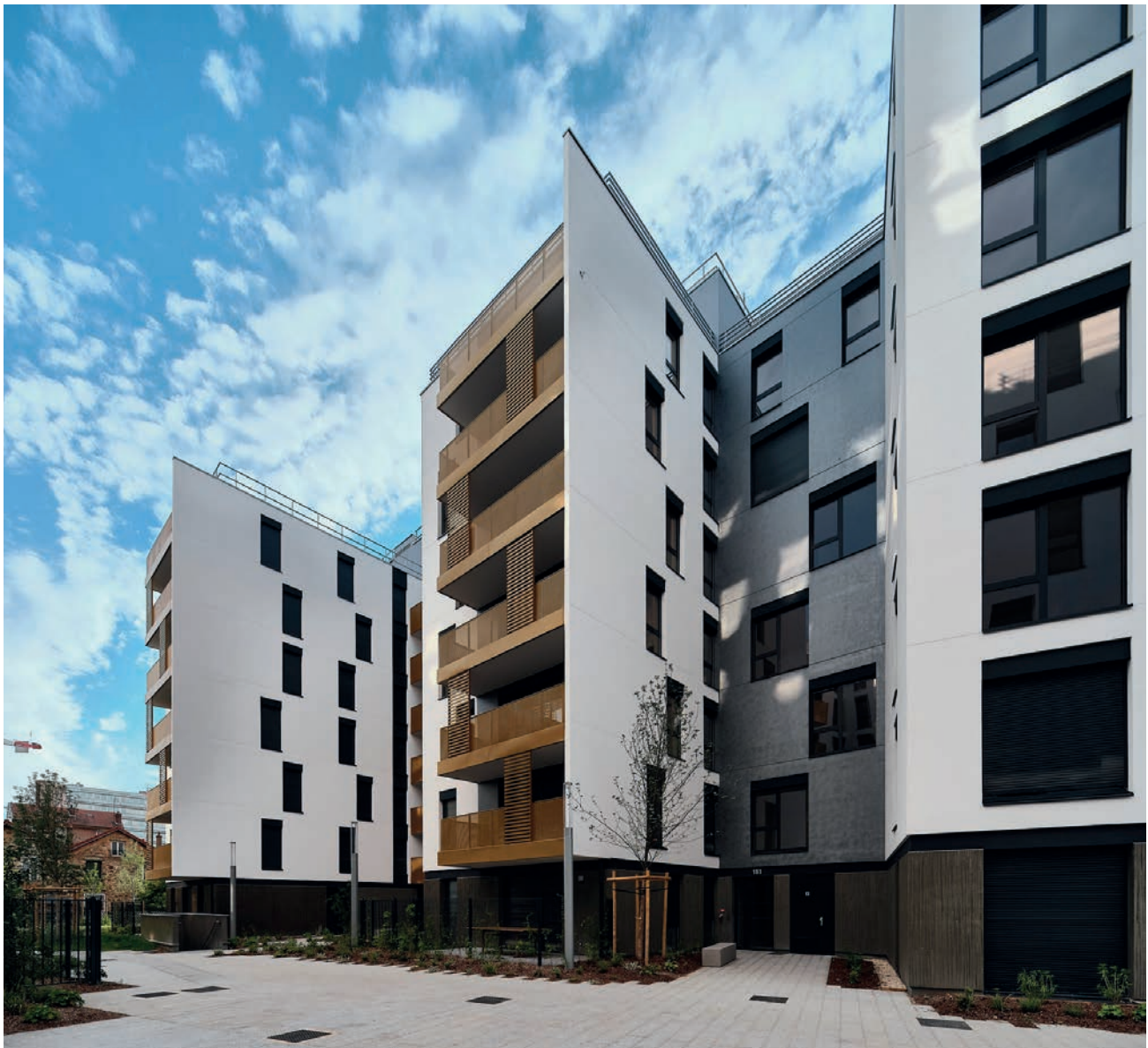
À Bagneux, une ancienne parcelle de bureaux recyclée en logements par Novaxia.
